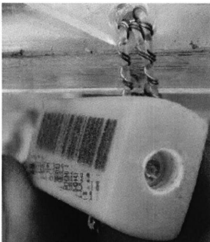
(Figura 2-10) Sello adecuadamente instalado.
