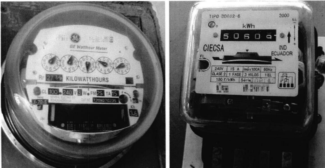
(Figura 1 – 1) Medidores electromecánicos.
