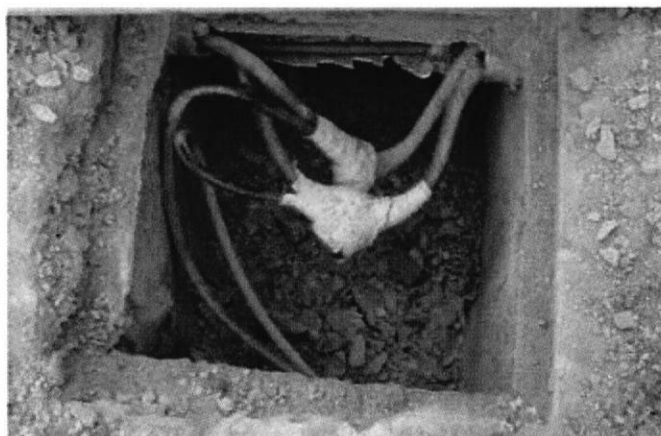
Figura (2-3) Bypass en caja de paso (baja tensión).
