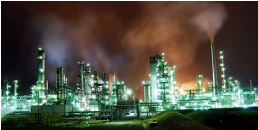
Figura 1: Refinería La Libertad-Santa Elena. Fuente: [7].
