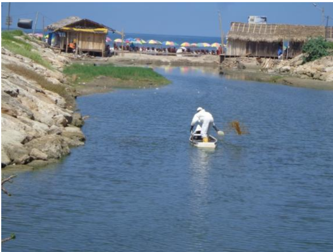
Figura 20. Estero de Montañita en temporada turística siendo intervenido para su posterior remediación. Fuente: Montañita se beneficia con labores de biorremediación de estero y construcción de alcantarillado http://www.andes.info.ec/es/regionales/montanita-beneficia-labores-biorremedacion-estero-construccion-alcantarillado.html
