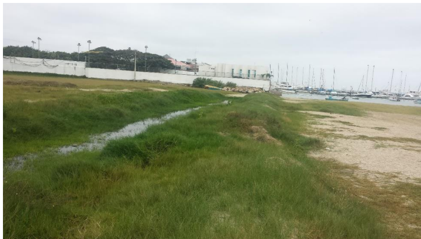
Figura 2. Alcantarilla abierta junto a descargas de aguas grises en el sector de San Lorenzo, Salinas. Fuente: Propia
