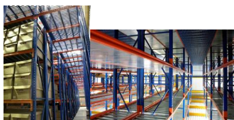
IMAGEN 11 SISTEMA DE ALMACEMIENTO ENTRE PISOS
