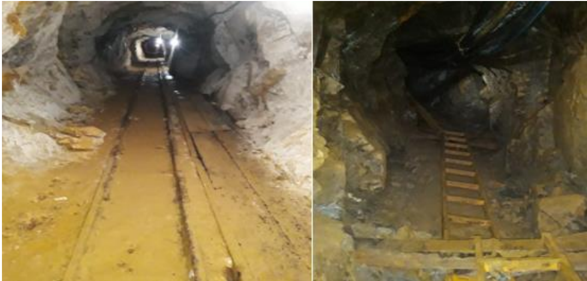
Figura 1.5 Situación de la mina Playitas (galería y chimeneas)
