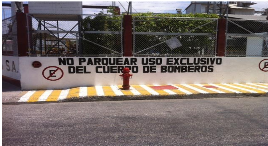
FIGURA 4.1 HIDRANTE (CUERPO DE BOMBEROS)
