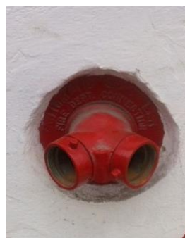
FIGURA 4.2 BOCA DE IMPULSIÓN
