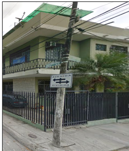
Figura 1.20 Poste ubicado en la ciudadela Urdesa Central, Av. Las Aguas y Laureles, 4 años después.
