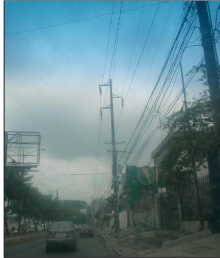
Figura 1.35 Poste ubicado en la Av. Carlos Julio Arosemena Tola.
