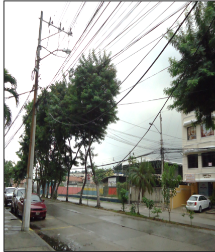
Figura 1.34 Poste ubicado en la ciudadela Nueva Kennedy, Av. Luis Orrantia y calle Manuel Eduardo Castillo
