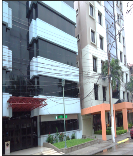
Figura 1.15 Poste ubicado en la ciudadela Nueva Kennedy, Av. Luis Orrantia y calle Nahím Isaías Barquet
