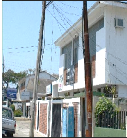
Figura 1.18 Poste ubicado en la Av. Francisco Boloña
