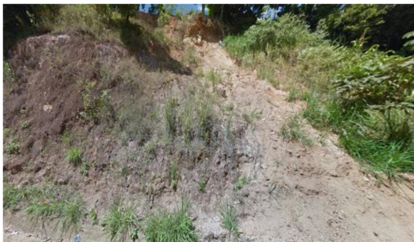
Figura 3.5: Vista general zona 3 en la vía Portovelo - Zaruma
