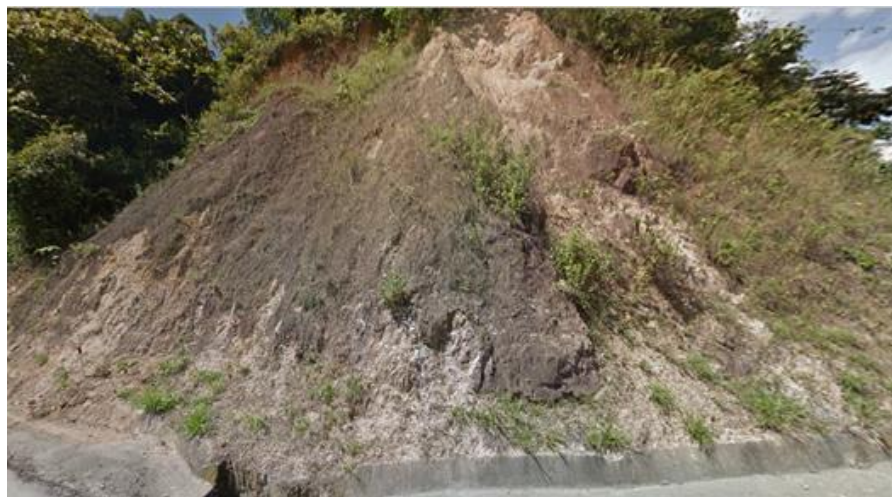
Figura 3.3: Vista general de la zona 1 en la vía Portovelo - Zaruma
