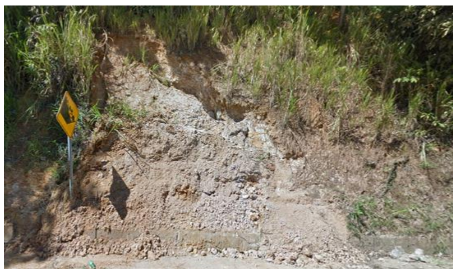
Figura 3.4: Vista general de la zona 2 en la vía Portovelo - Zaruma
