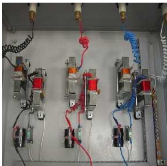
Moduladores de frecuencia y equipos de protección de transientes
