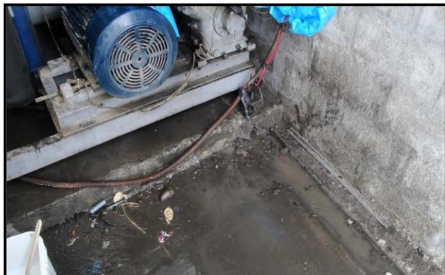
**FIGURA 7.10 CONDICIONES SUB-ESTÁNDARES EN CABLES ELÉCTRICOS 1**
