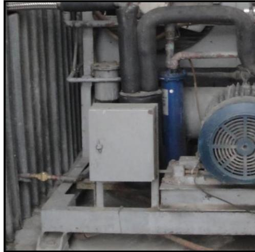
**FIGURA 7.15 CAJA INUTILIZADA DIFICULTA ACCESO EN LIMPIEZA**
