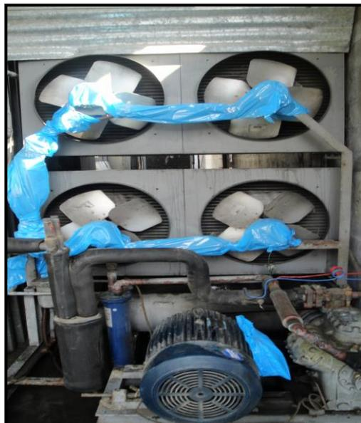
**FIGURA 7.9 PARTES ELÉCTRICAS IMPERMEABILIZADAS**
