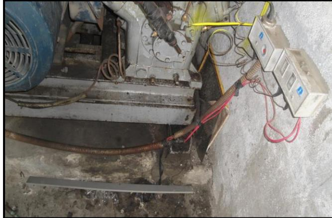
**FIGURA 7.3 CONEXIONES DE LOS PRESOESTATOS.**
