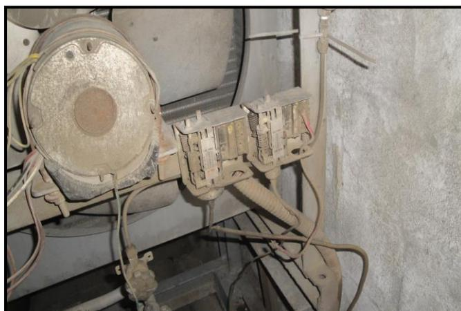
**FIGURA 7.5 PRESOESTATOS INUTILIZADOS COMPLICAN EL EQUIPO.**
