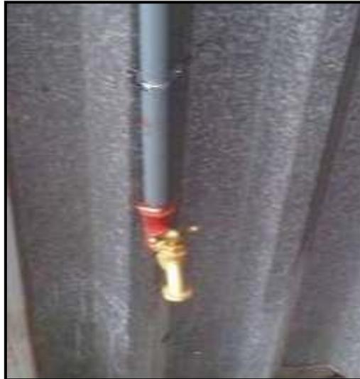
**FIGURA 7.8 PUNTO DE AGUA ESENCIAL PARA EFECTUAR LIMPIEZA DEL EQUIPO.**
