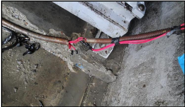
**FIGURA 7.11 CONDICIONES SUB-ESTÁNDARES EN CABLES ELÉCTRICOS 2**
