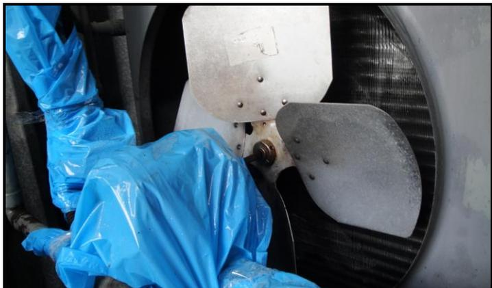
**FIGURA 7.12 VENTILADOR DEL CONDENSADOR SIN GUARDA**
