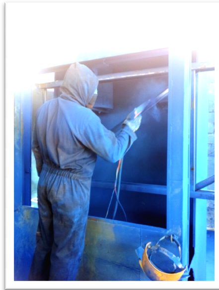
FIGURA 1.3 APLICACIÓN DE PINTURA Elaborado por: Christian Paredes, 2012
