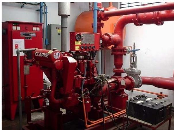
**FIGURA 4.1 PANELES DE CONTROL PARA LAS BOMBAS**
