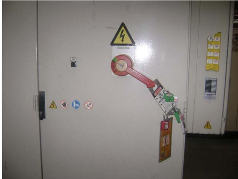
FIGURA 5.2 BLOQUEO GENERAL DE LA MÁQUINA
