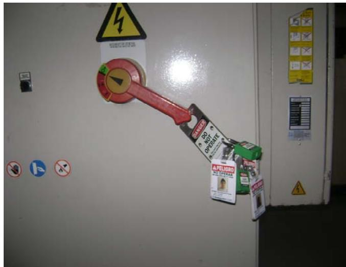
FIGURA 3.8 BLOQUEO DE MÁQUINA
