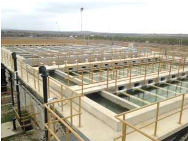
Figura 3.2. Sedimentación - Planta Potabilizadora Atahualpa
