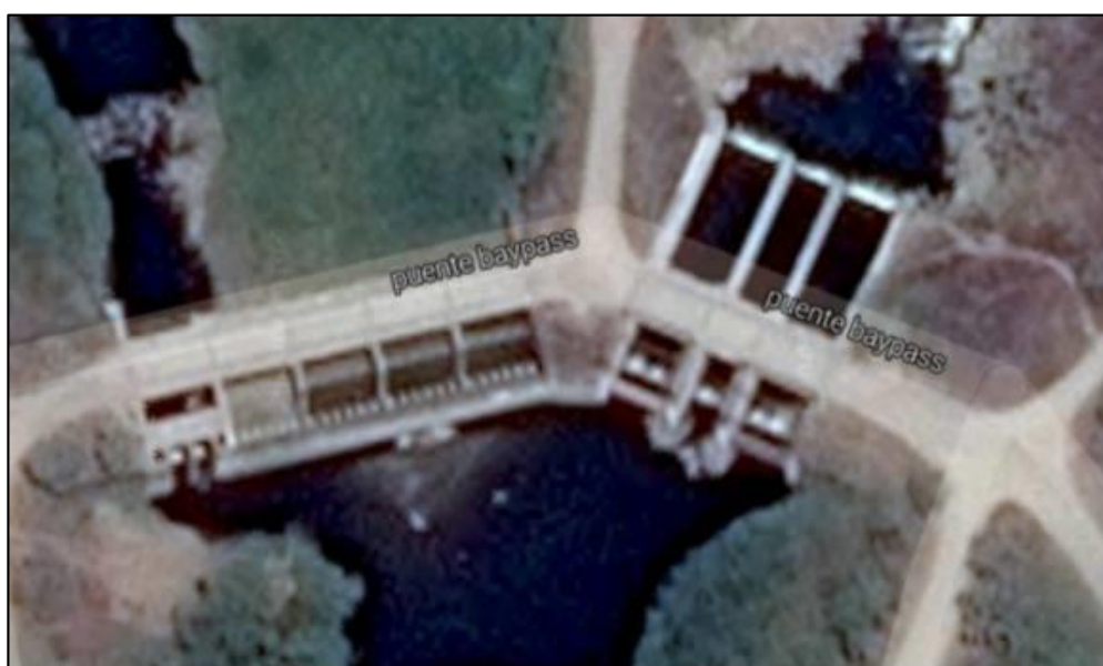
Figura 2.3: Presa compuesta por aliviadero y con compuertas rectangulares. Fuente: (Google Satellite, 2016).
