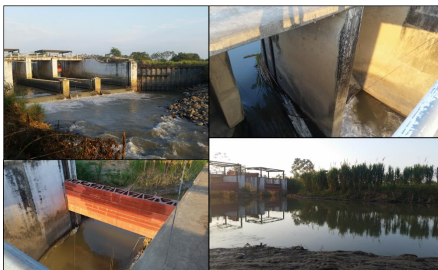
Figura 2.6: Vistas de represa con compuertas existente aguas arriba.
