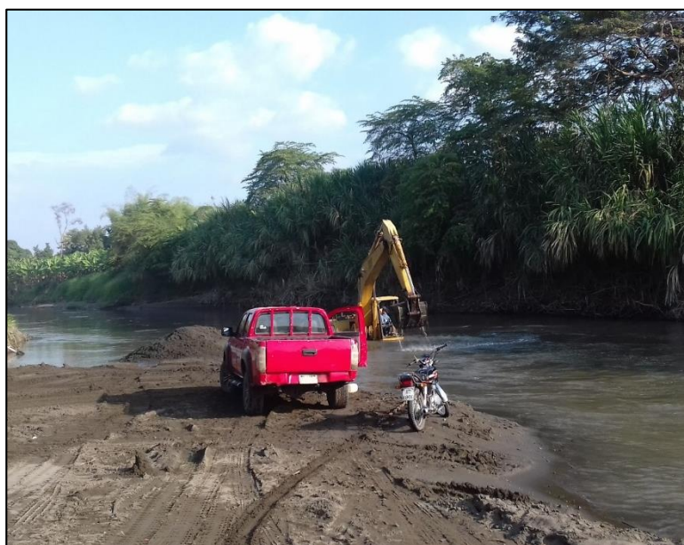
Figura 2.7: Excavadora extrayendo material en el Río Chimbo. Fuente: Autores.
