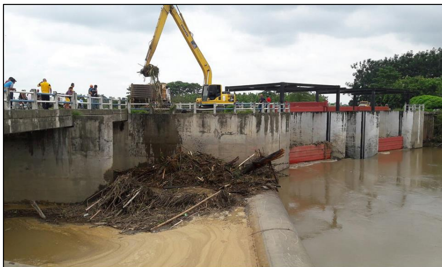
Figura 3.18: Palizada en la represa. Fuente: Prefectura del Guayas.
