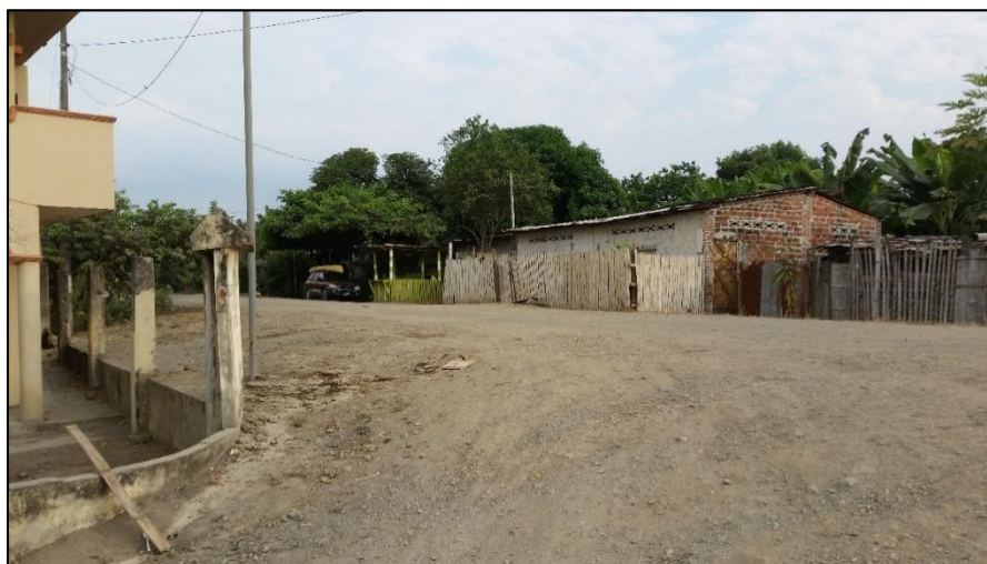
Figura 3.7: Calles sin aceras y bordillo, no poseen sistema de alcantarillado. Fuente: Autores.
