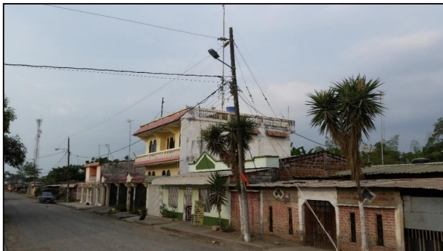
Figura 3.3: Poste de alumbrado público y cables de energía eléctrica en el sector. Fuente: Autores.
