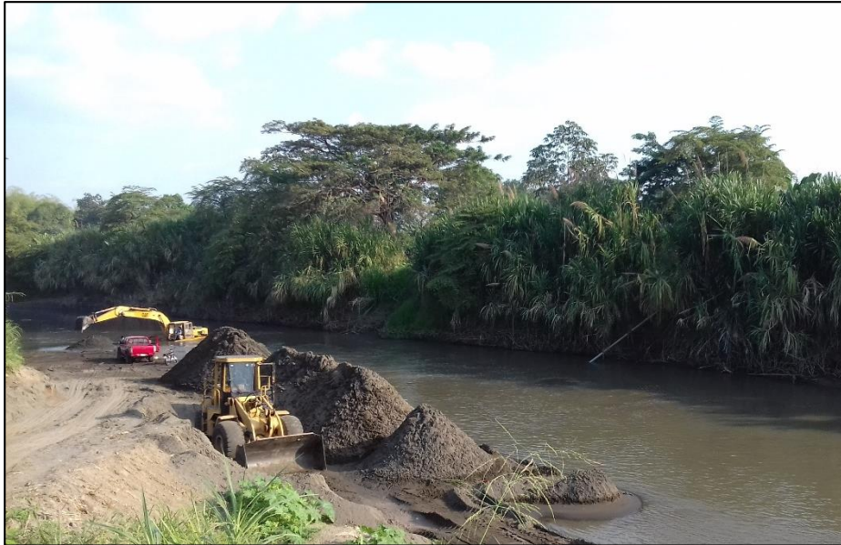
Figura 2.9: Maquinaria participando en extracción de arena en el río. Fuente: Autores.
