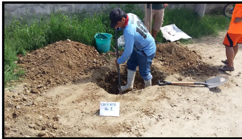
Figura 10.- Calicata #1 con coordenadas X=528380.6810 , Y= 9795535.7180 .
