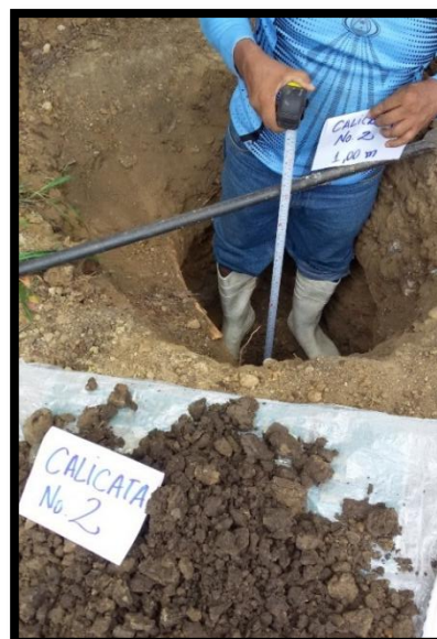
Figura 15.- Calicata #2 excavación a toma de muestras a 1,00 m
