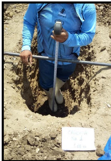
Figura 12.- Calicata #1 excavación a toma de muestras a 1,00 m
