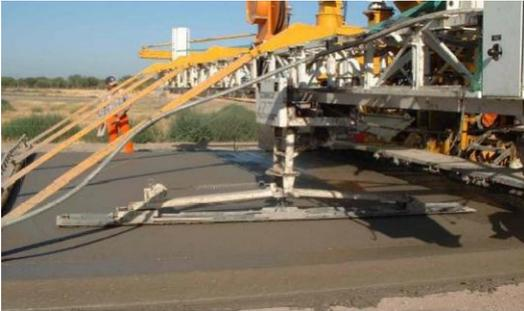
Figura No.3 Llana flotadora
