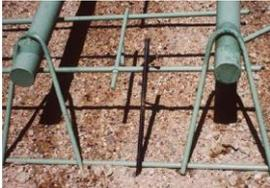
Figura No.1 Varillas de transferencia de carga
