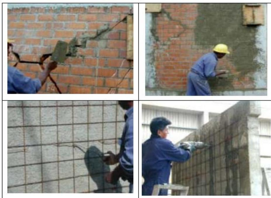
**Figura 4.1** Proceso de reparación para el reforzamiento del muro con malla electrodoldada.
