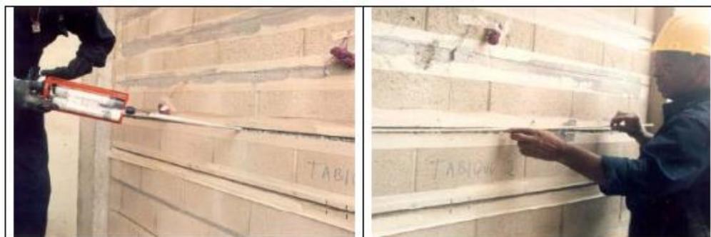
**Figura 4.6 Proceso de colocación de varillas de fibra de vidrio en los muros de mampostería**
