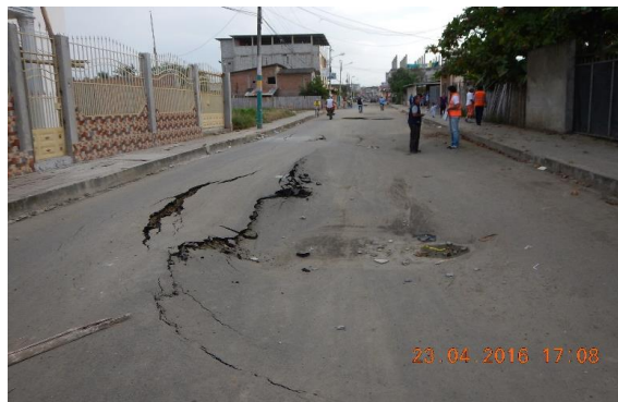
Fig. 2: Sinkhole en sitio Tosagua (D. Besenzon, 2016)
