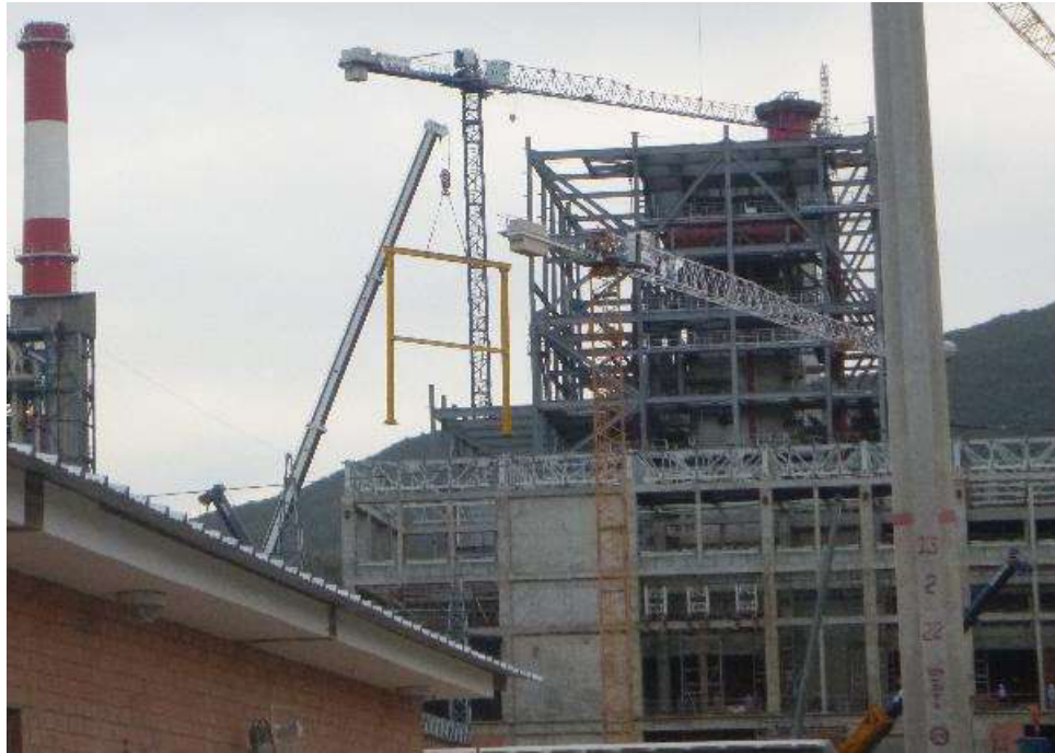
Foto 1 Instalacion de estructura de soporte
