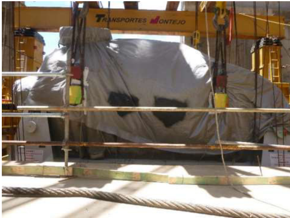
Foto 6 Izaje de la turbina
