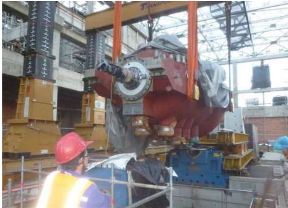
Foto 8 Posicionamiento final de la turbina
