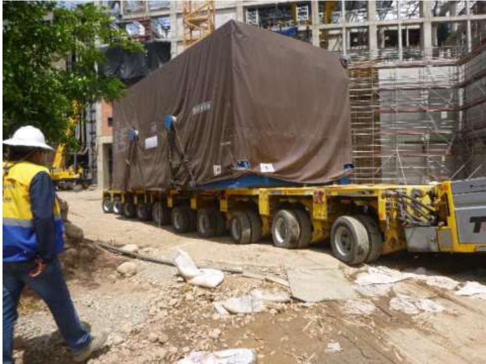
Foto 3 Transporte del generador
