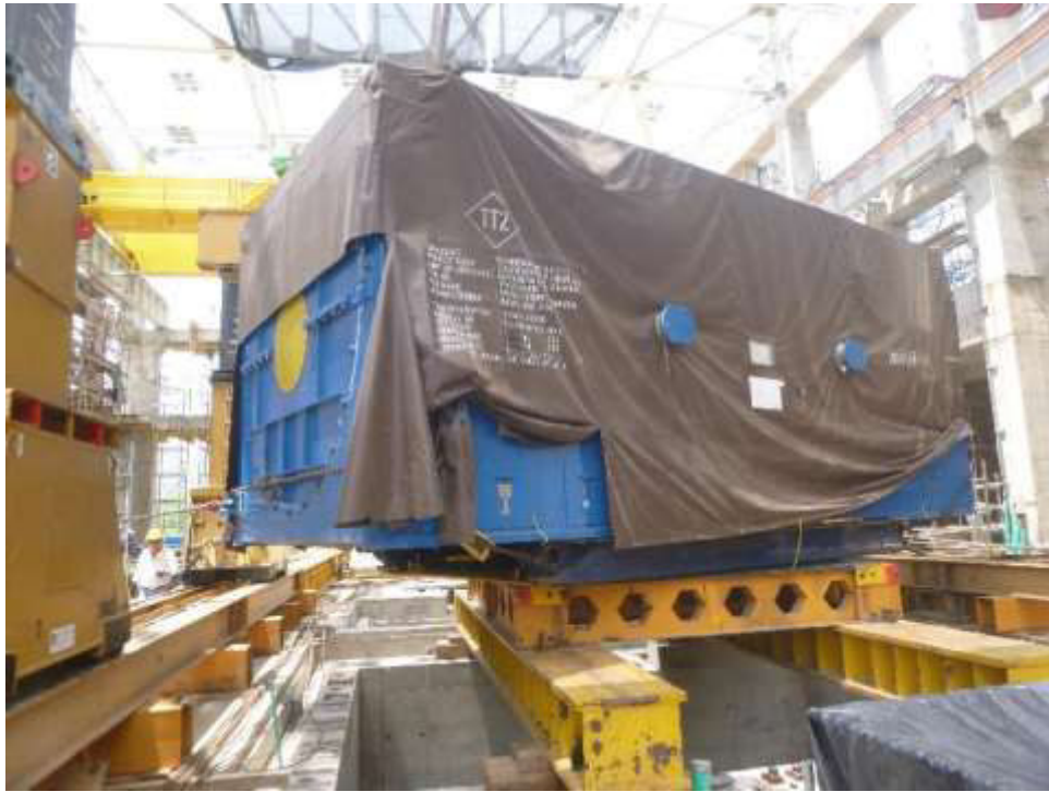
Foto 5 Giro del generador
