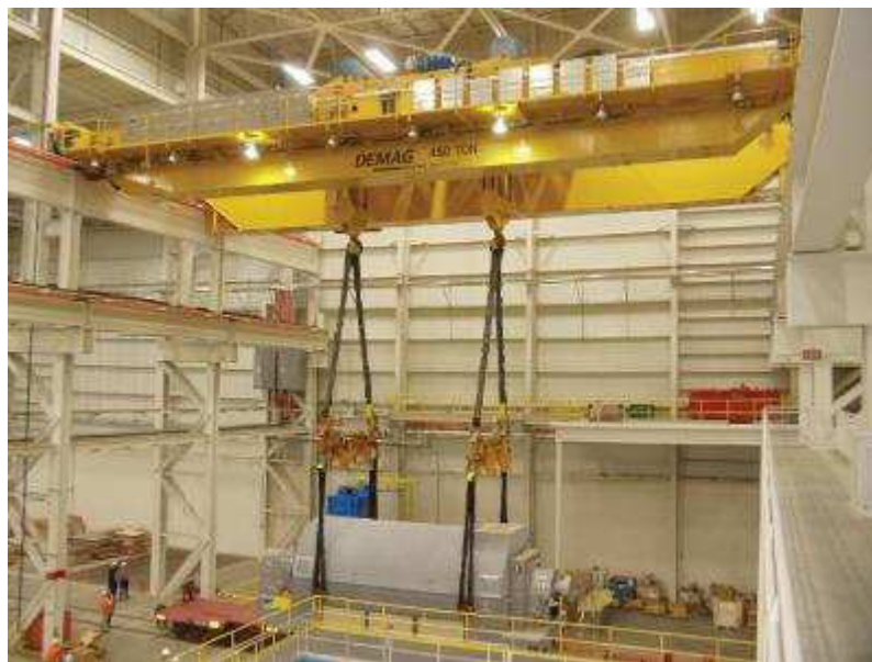
FIGURA 5. IZAJE DE GENERADOR CON PUENTE GRÚA
