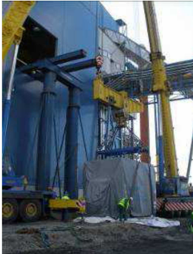
FIGURA 7. IZAJE CON GRÚA MÓVIL MÁS SISTEMA DE RIELES
