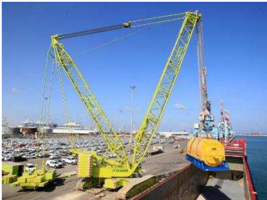
FIGURA 6. IZAJE DE GENERADOR CON GRÚA MÓVIL.
