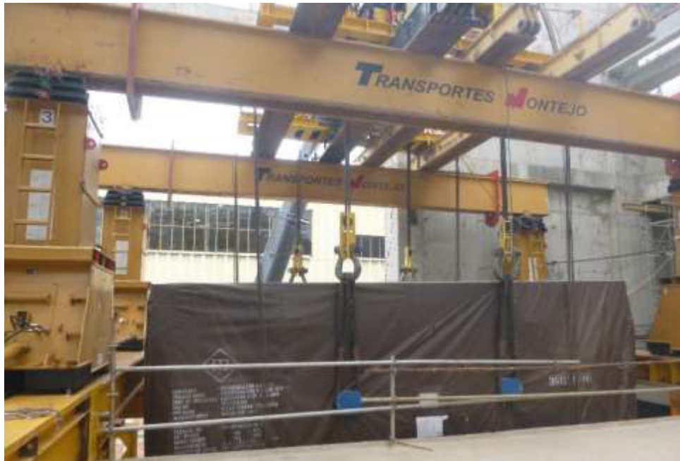
Foto 4 Izaje del generador
