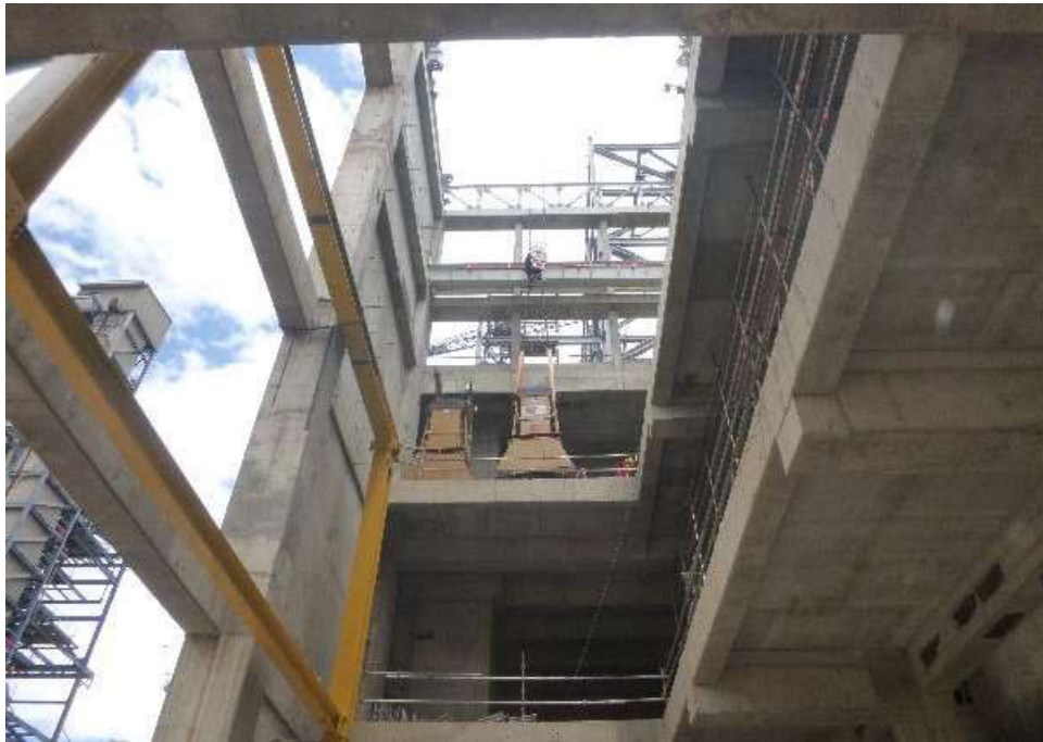
Foto 2 Instalación de estructura de soporte
