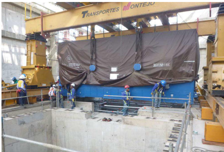
FIGURA 8. IZAJE CON GANTRY Y STRAND JACKS
