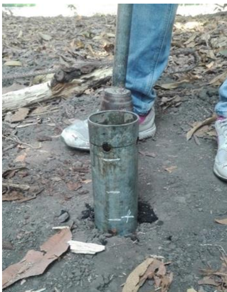
Figura 2-19 Perforación realizada. Fuente: Ponce, P., Rodríguez, CH., 2016.
