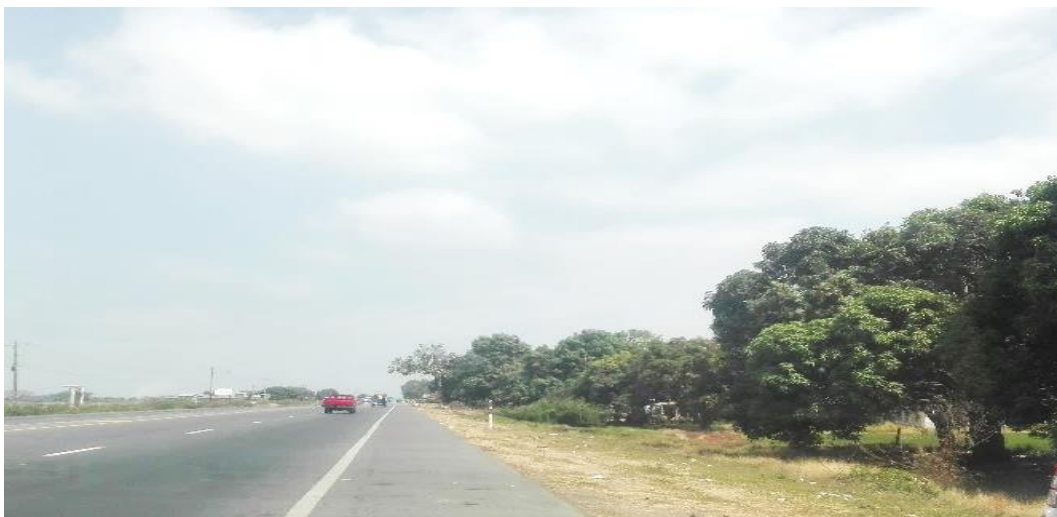
Figura 2-3 Vía de acceso al recinto Barbasco del Rio Fuente: Ponce y Rodríguez, 2016
