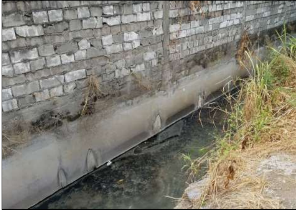
Figura 5.10 Canal rectangular revestido de hormigón armado ubicado atrás del Colegio “Espíritu Santo”.
