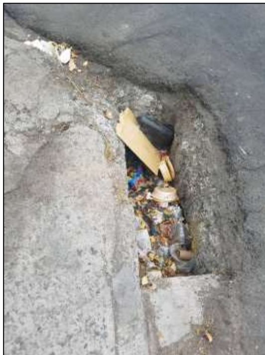
Figura 3.15 Falta de mantenimiento en sumideros, Urbanor.
