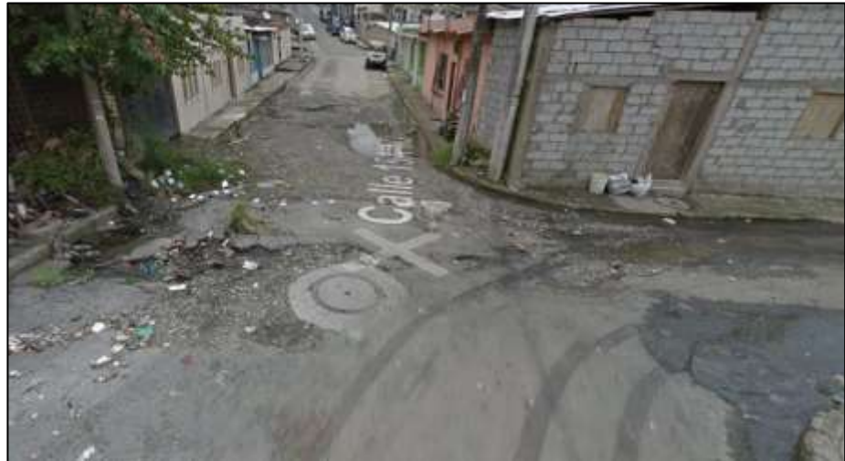
Figura 3.12 Erosión hídrica en calles a causa del invierno en el sector de Urbanor.
