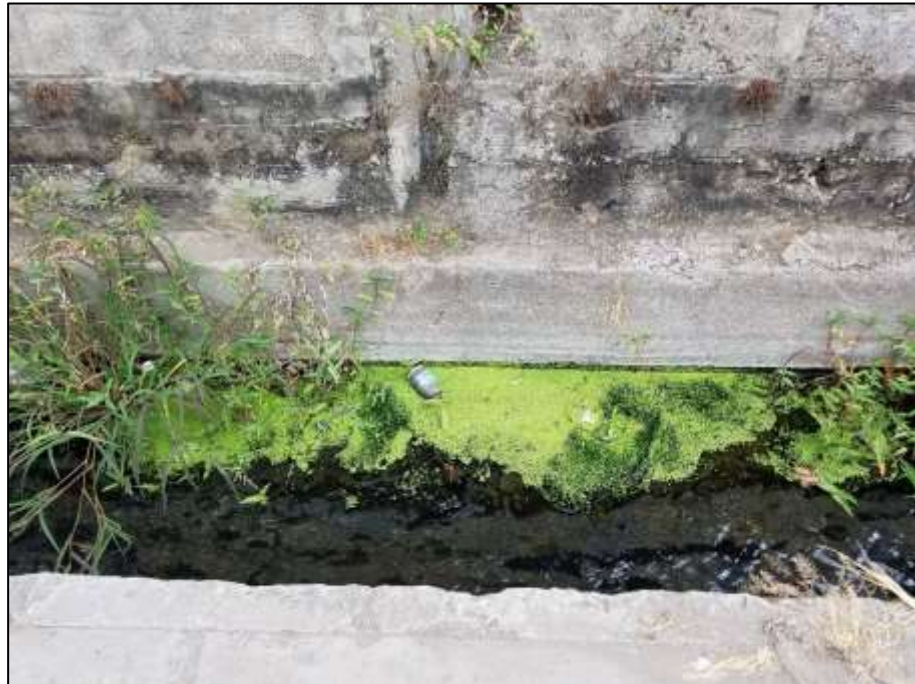
Figura 3.17 Formación de algas en canales de drenaje por falta de mantenimiento.
