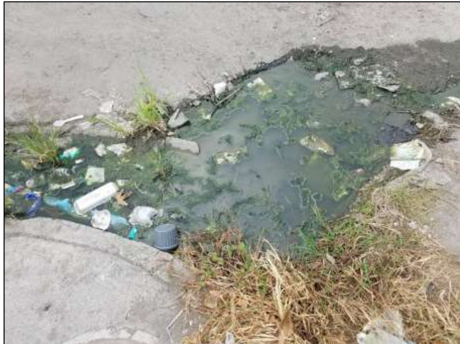
Figura 3.18 Contaminación en calles a causa del agua empozada en Urbanor.
