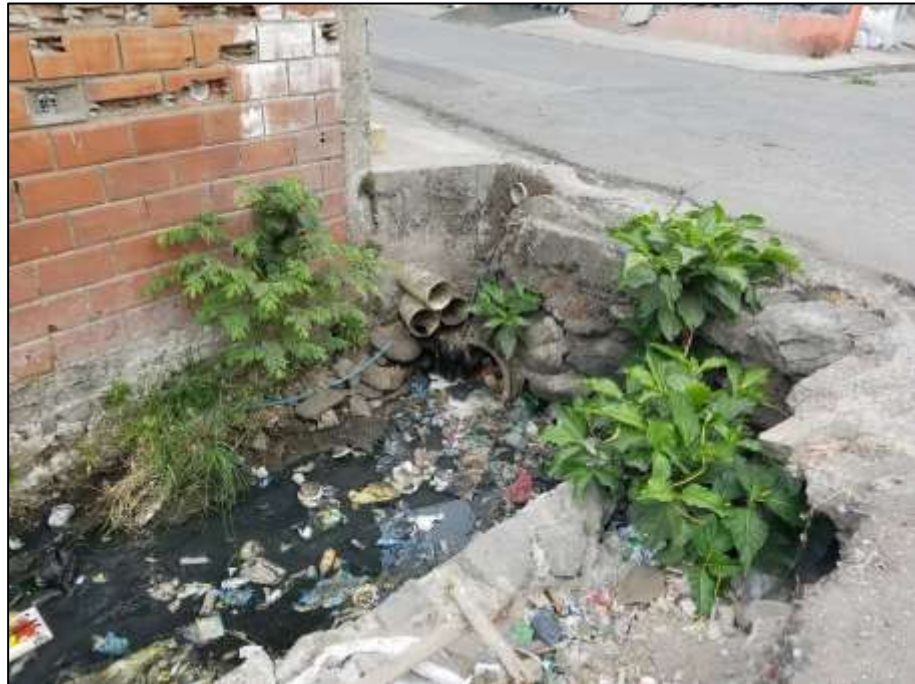
Figura 3.16 Falta de mantenimiento en canales de drenaje en Urbanor.
