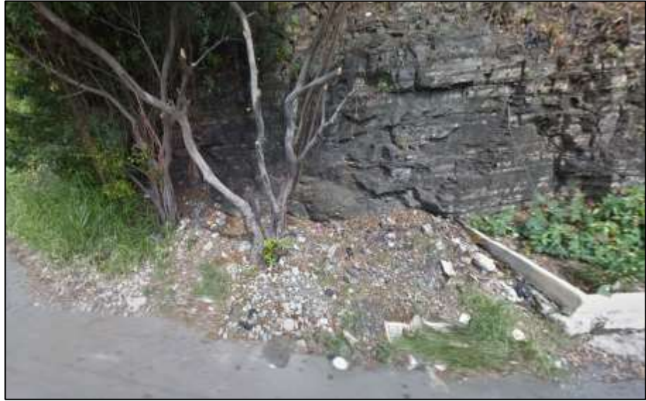
Figura 3.11 Erosión hídrica en estratos rocosos a causa del invierno.
