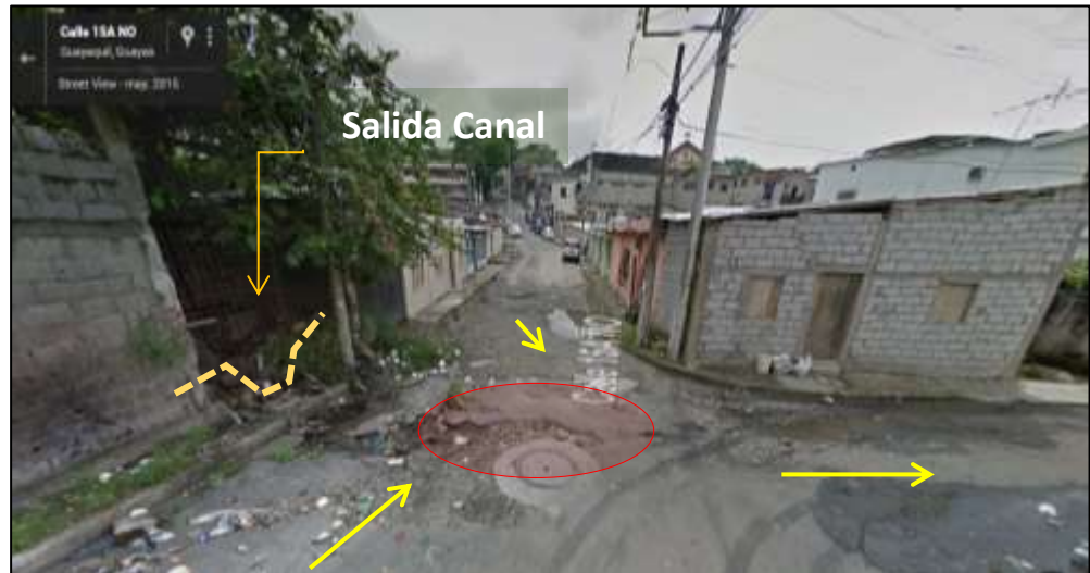
Figura 5.6 Punto crítico (A1), erosión y acumulación de AALL a la salida del canal “Santa Catalina”.
