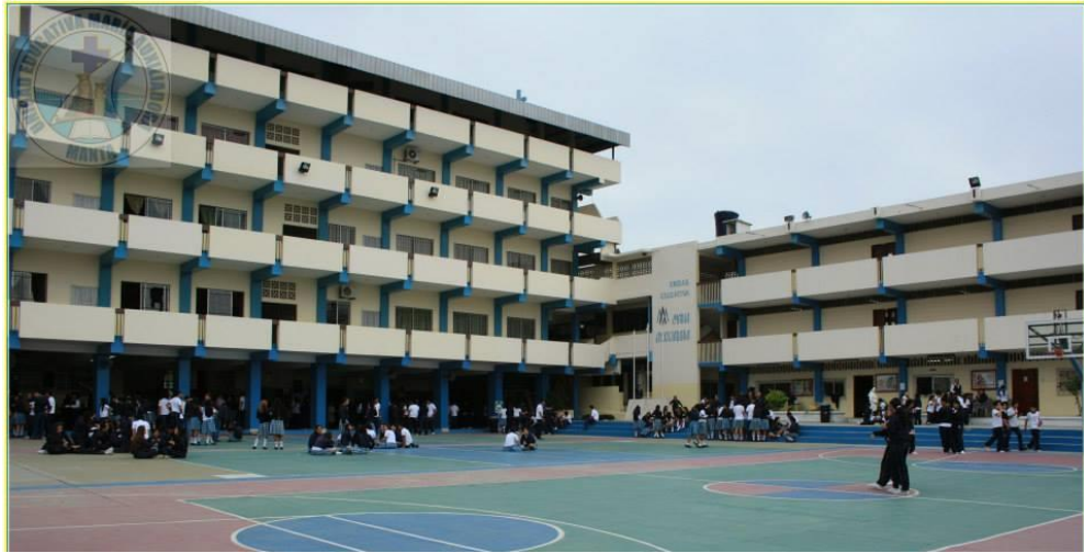
Figura 1-9 Edificación antes de ser Derrocada. Fuente: (Salesianas, 2016)
