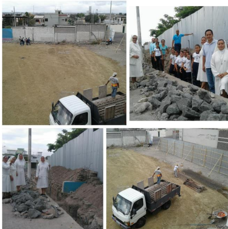
Figura 1-10 Inicio de Construcción de edificación para aulas y oficinas de la UESMA. Fuente: Fotografía de uno de los profesores de UESMA Lcdo. Bailón.
