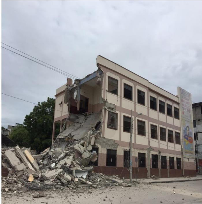
Figura 1-3 Derrocado de la Unidad Educativa Salesiana San José tras falla estructural en su edificación.
