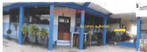
Fig.2 Instalaciones del área de cocina y acceso a la zona de aulas
