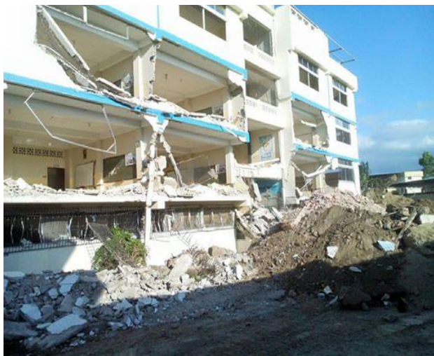
Figura 1-4 UESMA afectada por el terremoto antes de su demolición. Fuente: (Salesianas, 2016).
