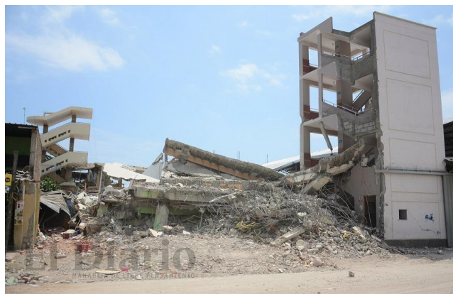
Figura 1-2 Colapso de la Unidad Educativa Leonie Aviat tras el terremoto del 2016. Fuente: (EIDiario, 2016)
