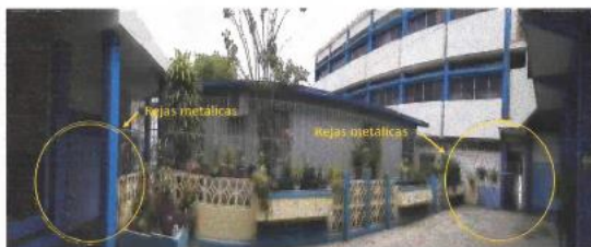
Fig.5 Rejas metálicas colocadas como medidas de seguridad para impedir el acceso de los estudiantes al área de cocina
