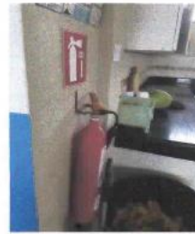
Fig.6 Extintores identificados y ubicados en el área de cocina
