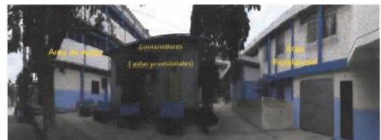
Fig.7 Identificación de área de Aulas, contenedores adecuados para aulas provisionales y áreas residencial.
