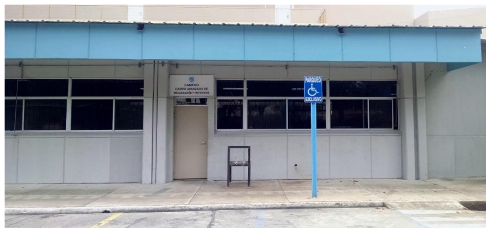
FIGURA 4.4: Vista frontal del Laboratorio CAMPRO de la FIMCP – ESPOL
