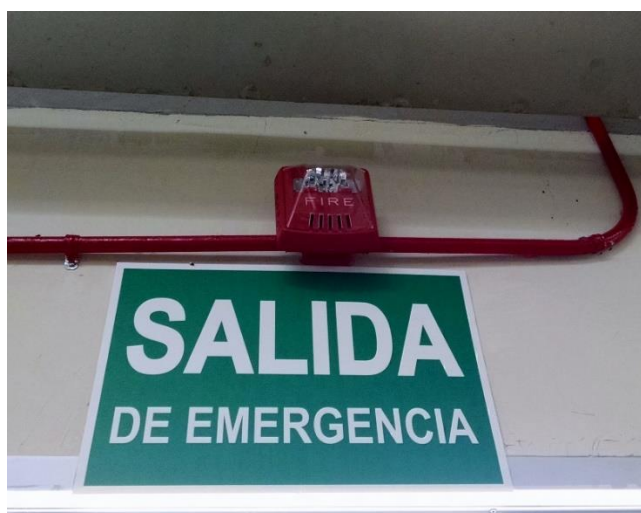
FIGURA 3.51: Sirena de Alarma de incendio del Laboratorio CAMPRO
