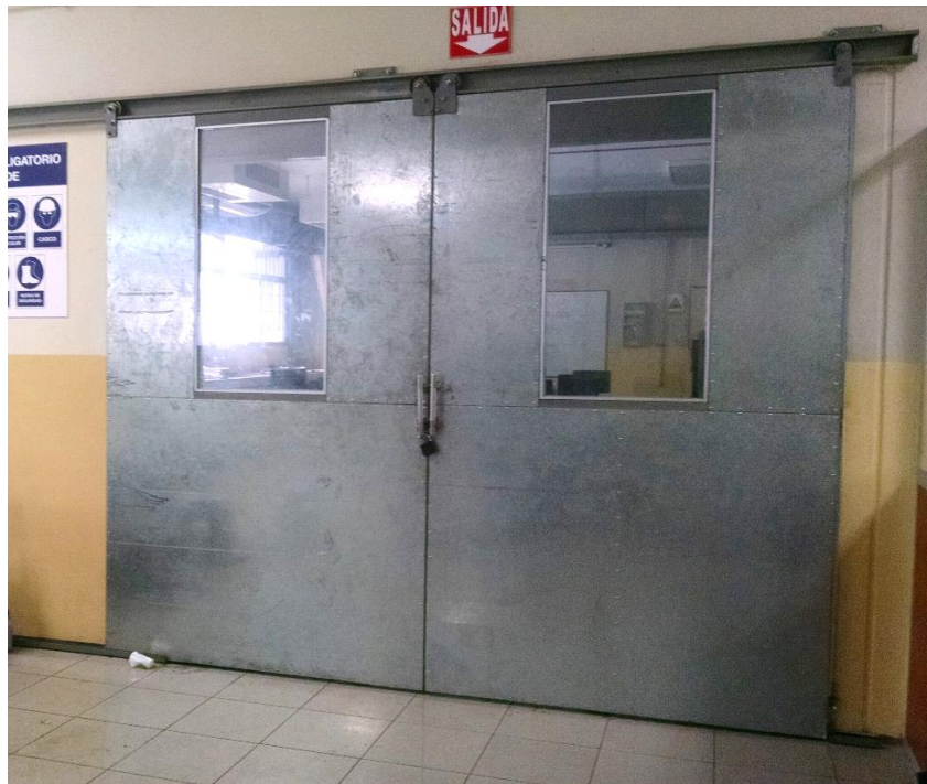
FIGURA 3.1: Puerta de separación entre el Laboratorio CAMPRO y Laboratorio de Mecatrónica
