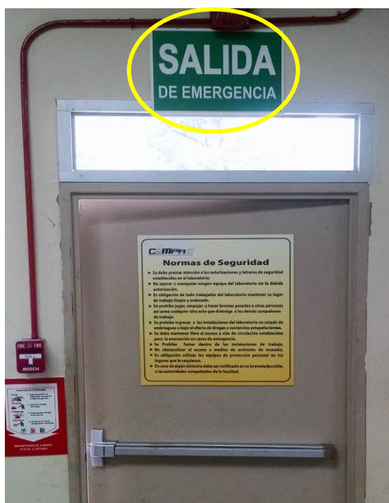
FIGURA 3.50: Señal de información de Salida de Emergencia del Laboratorio CAMPRO
