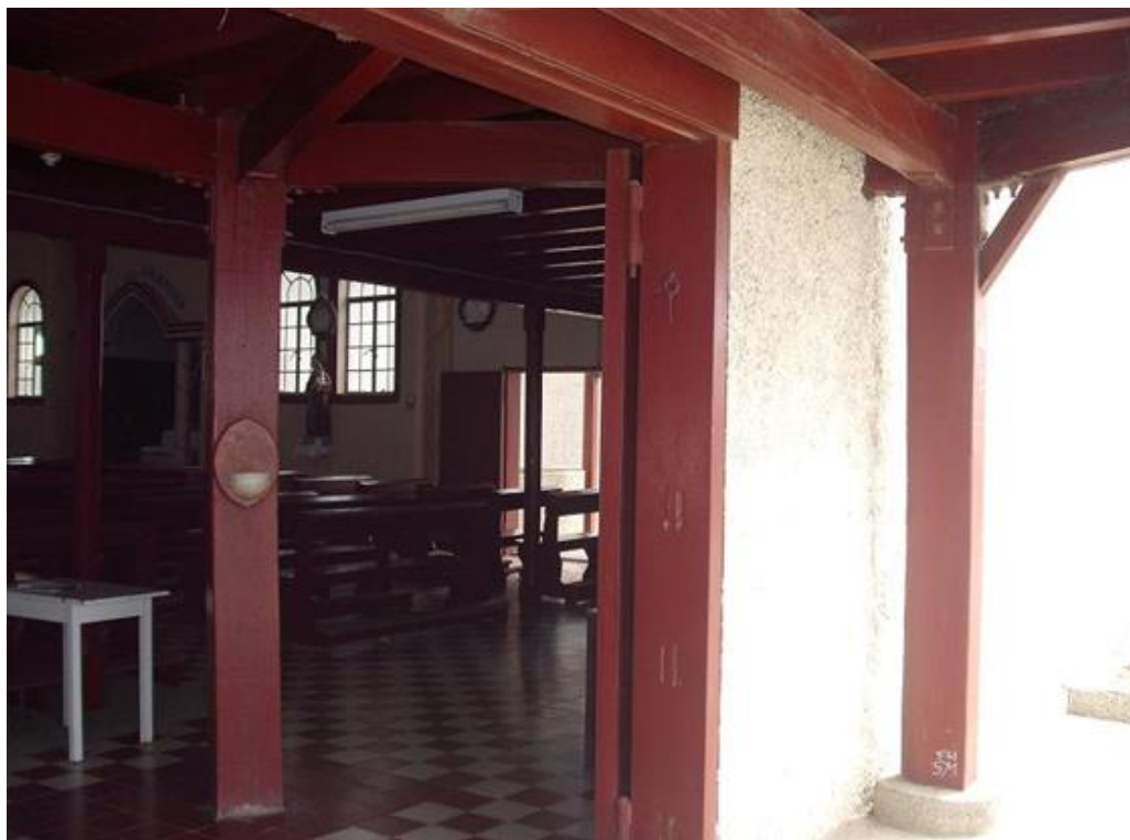
Fotografía N. 4 Iglesia San José de Ancón
