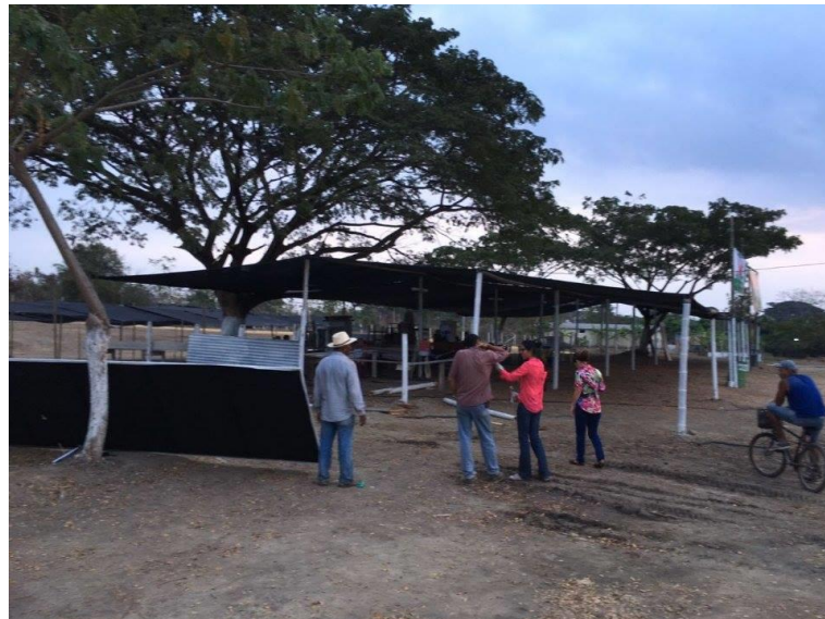
Figura 11. Montaje de stand de alimentación
