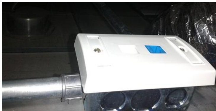
Figura 2.6: Instalación de Jacks
