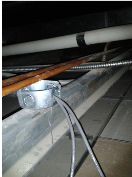
Figura 2.5: Instalación de cableado
