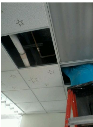
Figura 2.4: Instalación de tuberías sobre techo falso
