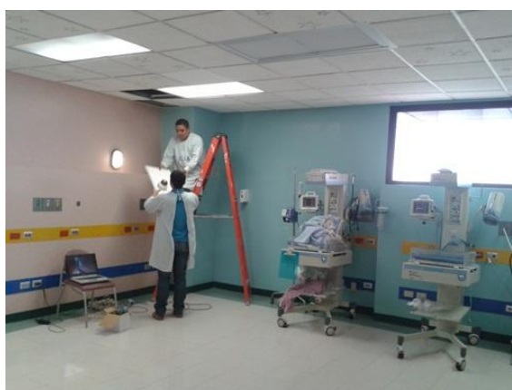
Figura 2.3: Instalación de cámara en área de UCI
