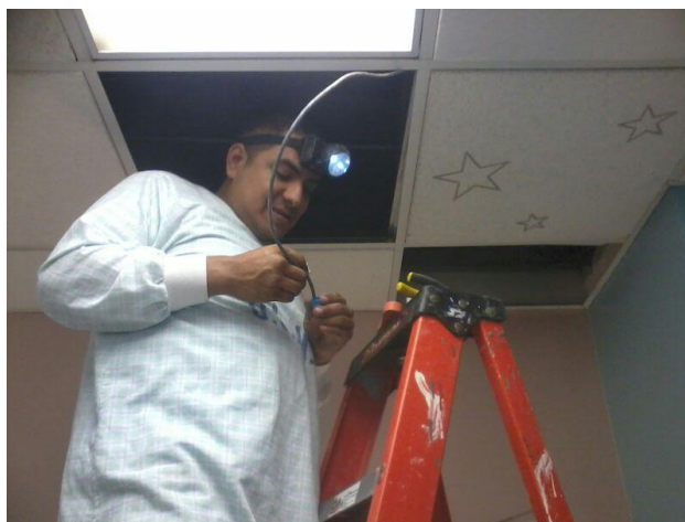
Figura 2.7: Instalación de cámaras
