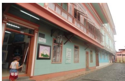
Imagen 8: Casa Gabela Fuente: Elaboración propia
