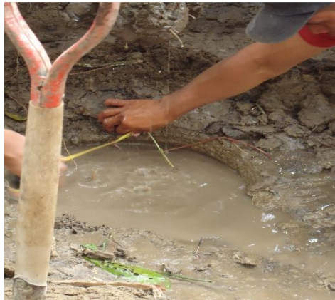
Figura 3 Pozo perforado en Manglaralto Fuente: Autor
