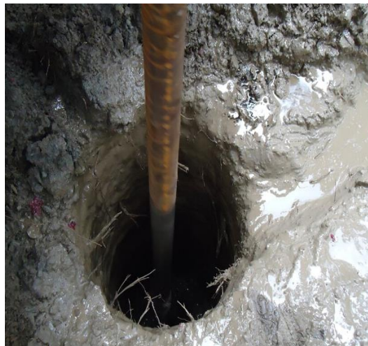
Figura 19 Perforación por rotación Fuente: Autor
