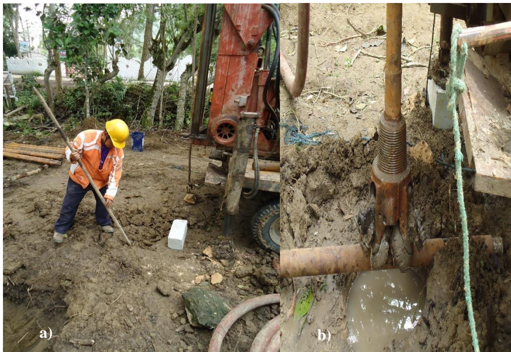
Figura 22 a) Inicio de la perforación b) Perforador tricónico Fuente: Autor
