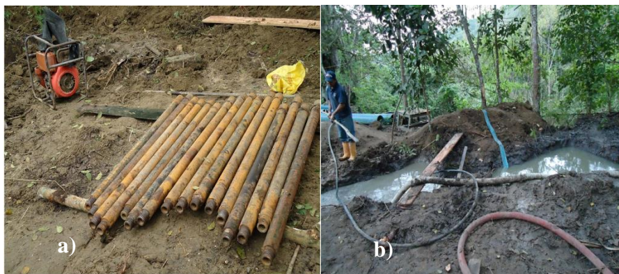
Figura 21 a) Extensiones b) Balsas de lodo Fuente: Autor
