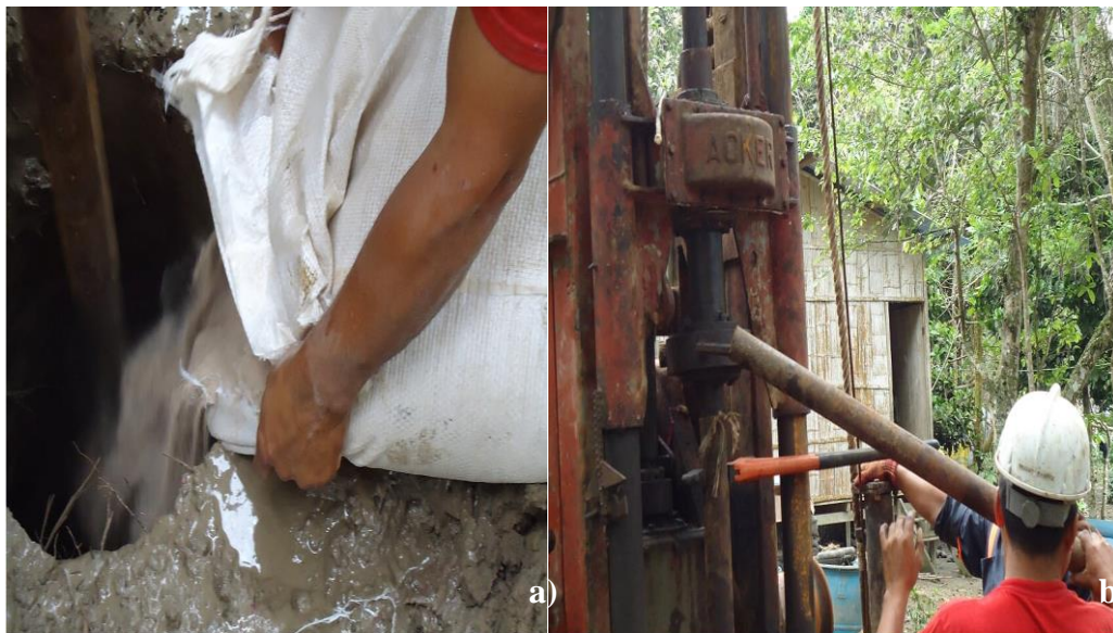
Figura 23 a) Aplicación de bentonita b) Ajuste de extensiones Fuente: Autor
