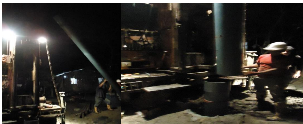
Figura 28 a) Nivelación del tubo b) Unión del tubo Fuente: Autor
