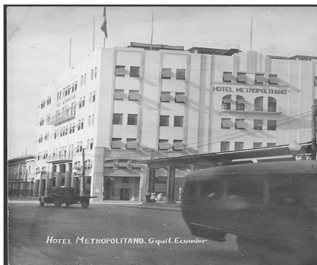
Foto No 2: Edificio del antiguo Hotel Metropolitano
