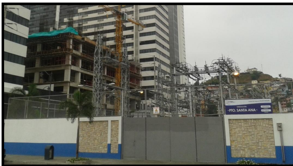
Figura 3.1: Subestación Puerto Santa Ana.
