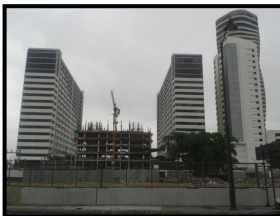
Figura 3.18: Fotografía del terreno y los potenciales obstáculos.
