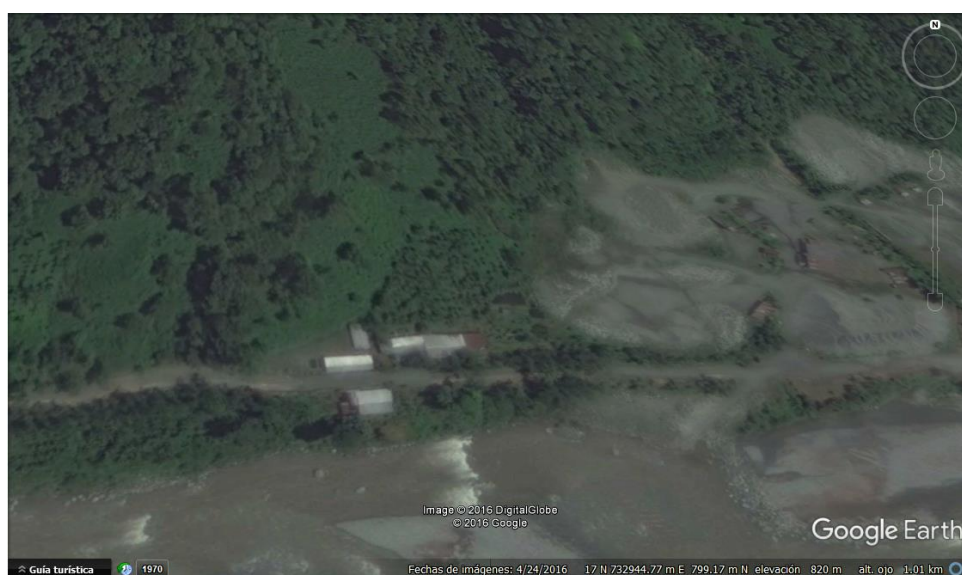
Imagen 4.- Campamento San Miguel de los Bancos Fuente: Google Earth
