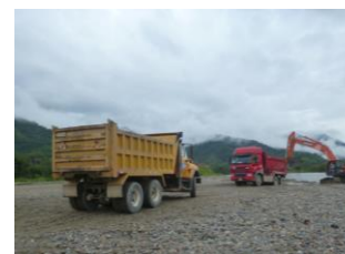
Foto 7.- Maquinaria campamento San Miguel de los Bancos
