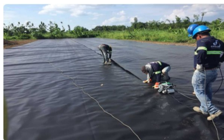
Figura 3. 14. Proceso de termosellado
