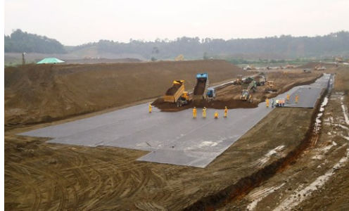
Figura 3. 13. Colocación de geomembrana
