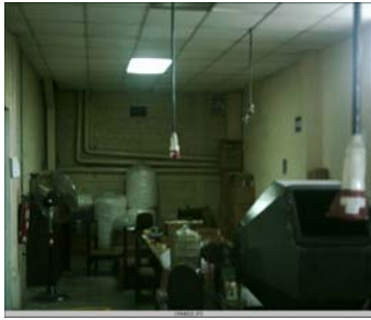
Figura 1. Instalaciones de la planta
