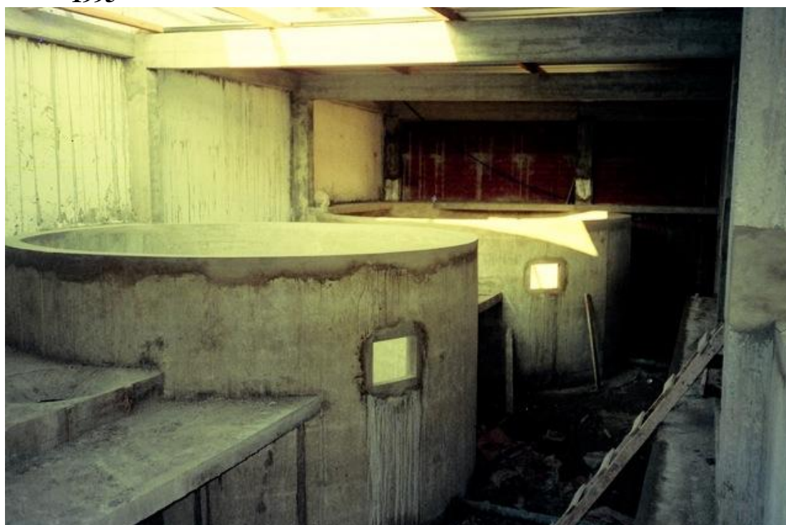
Figura # 17. Construcción de los tanques de maduración de peces en 1995
