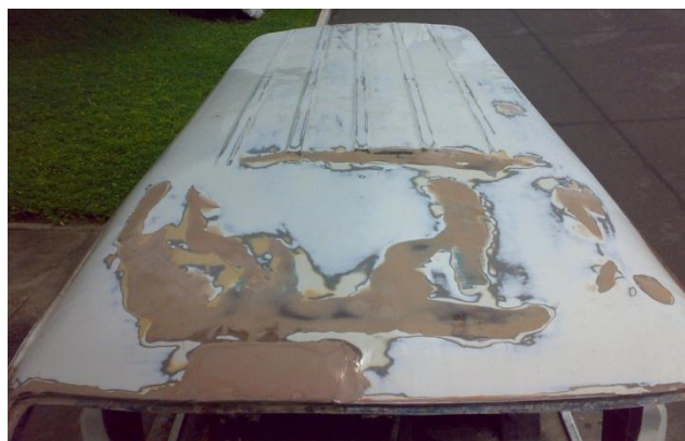
5-8 MASILLADO DE PARTE SUPERIOR DE LA CAMIONETA
