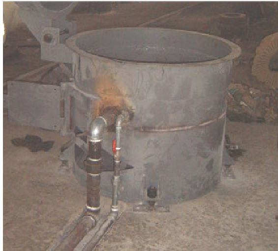
FIGURA 2.48 TUBERÍA DE ALIMENTACIÓN Y DRENAJE DE AGUA
