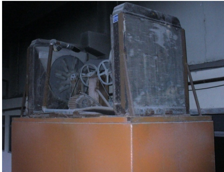
FIGURA 2.46 SISTEMA DE RADIADORES UBICADOS EN LA PARTE SUPERIOR DE LA TORRE DE ENFRIAMIENTO.
