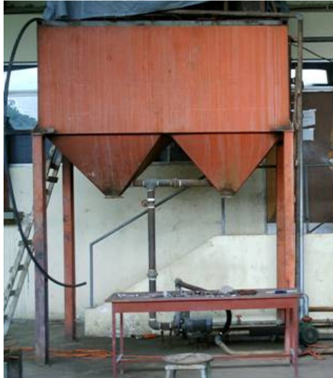
FIGURA 2.45 TORRE DE ENFRIAMIENTO
