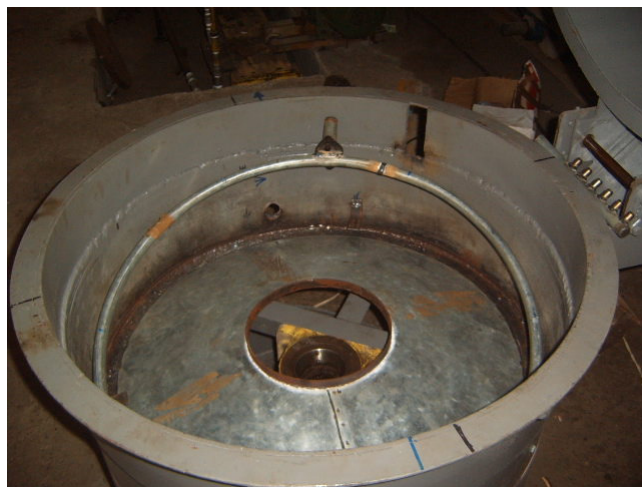
FIGURA 2.47 ETAPA DE CONSTRUCCIÓN ANILLO CIRCULAR PARA ENFRIAMIENTO
