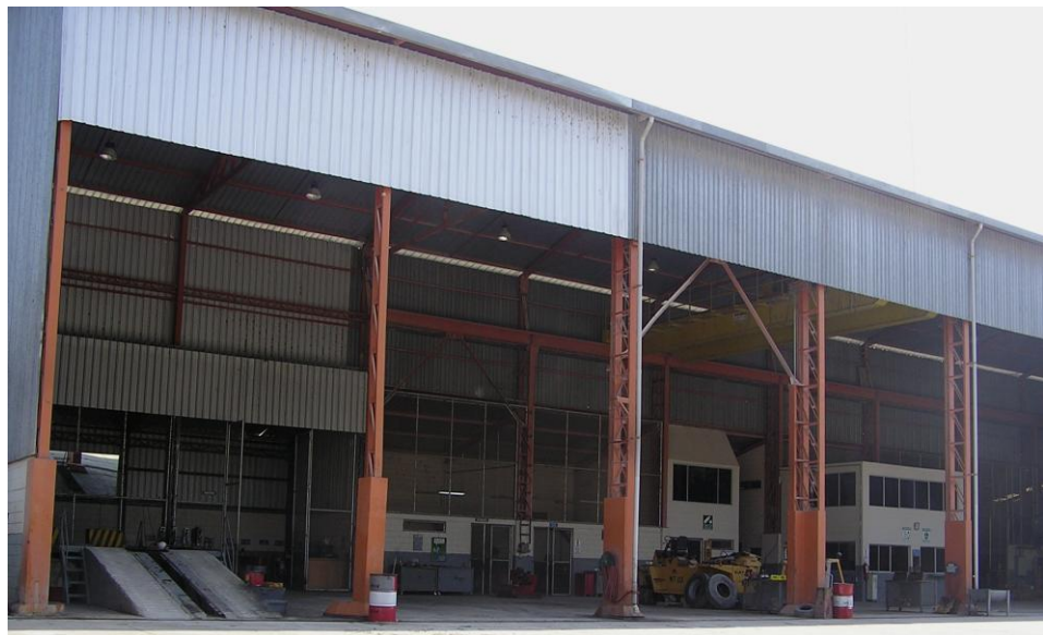
FIGURA 2.1 TALLER MECÁNICO PARA REPARACIÓN Y MANTENIMIENTO
