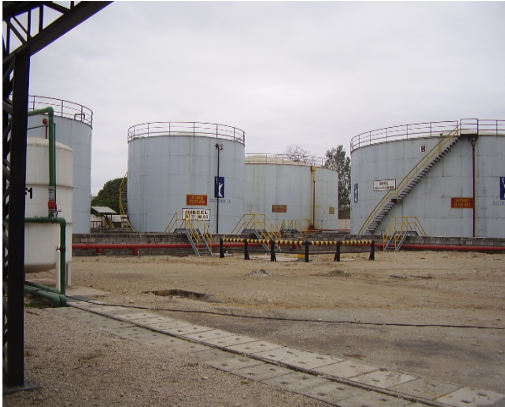
FIGURA G.3 TANQUES DE ALMACENAMIENTO DE COMBUSTIBLE
