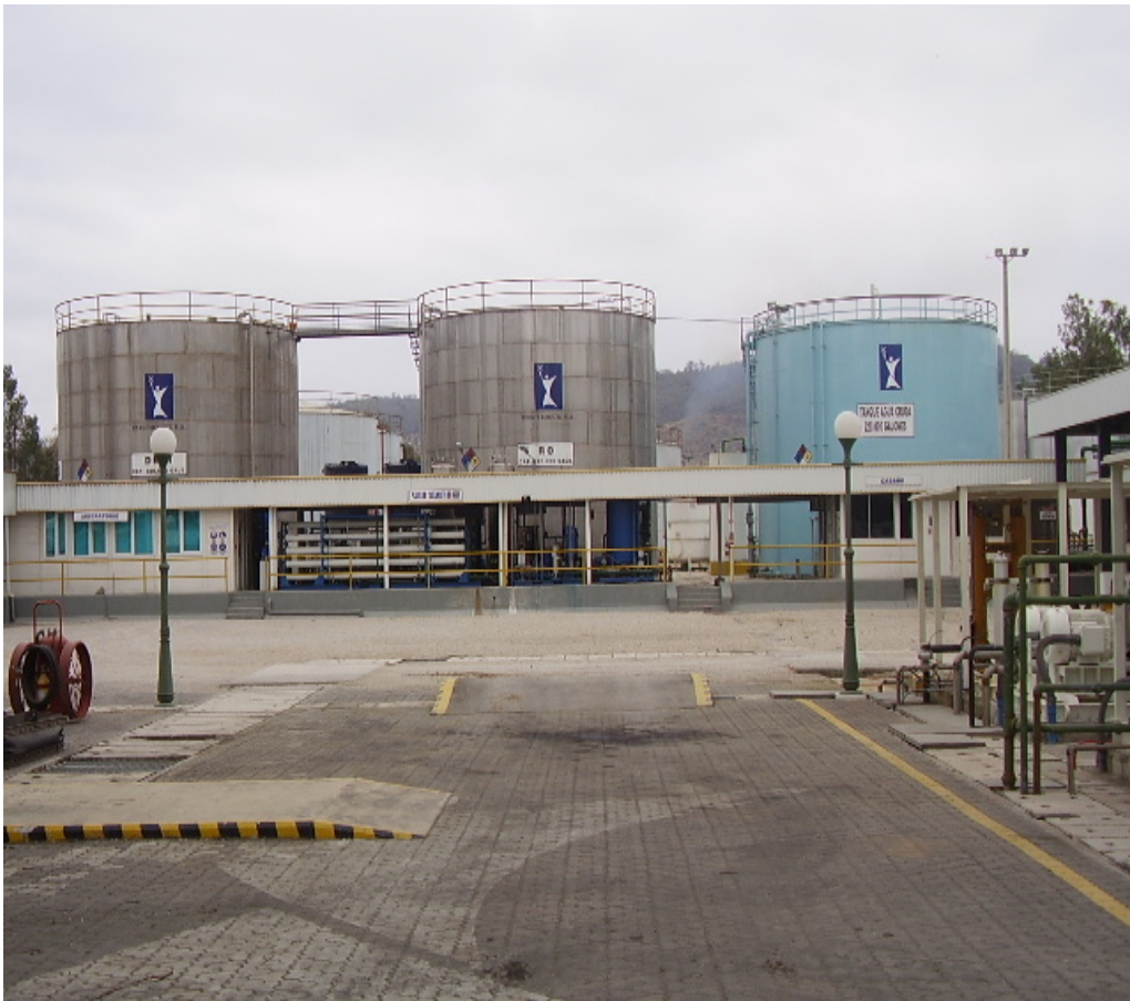
FIGURA G.1 TANQUES DE ALMACENAMIENTO DE AGUA
