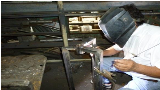
Figura 14. Soldadura TIG del Rotor
