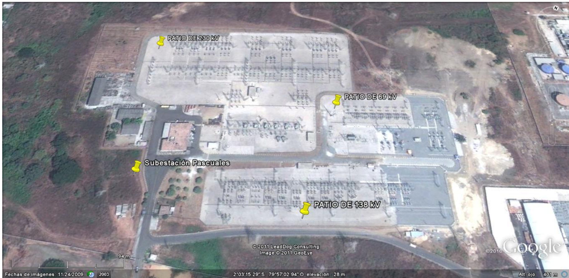
Figura C: Vista panorámica de la subestación Pascuales
