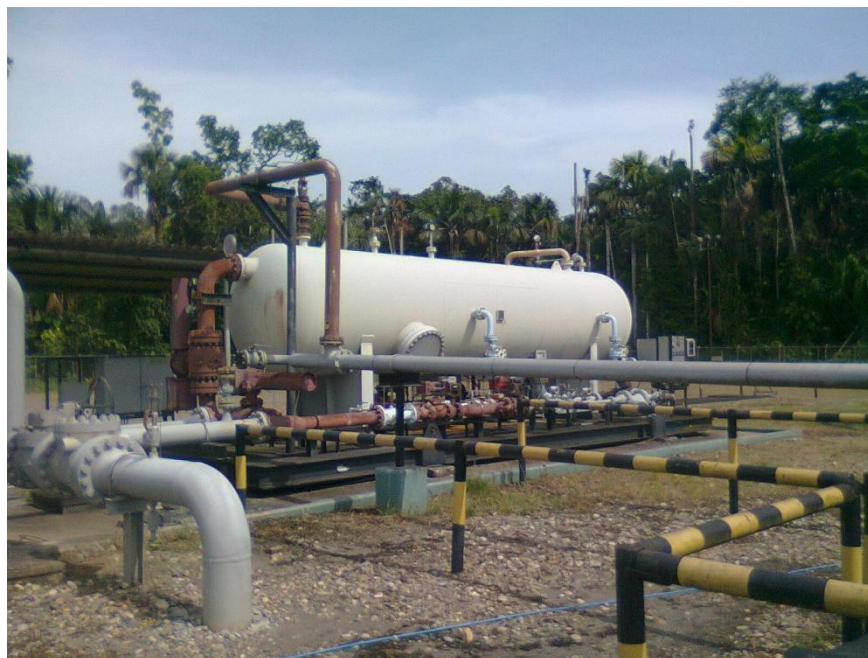
Figura 3-14: Separador de Prueba del Well Pad Fanny 20.
