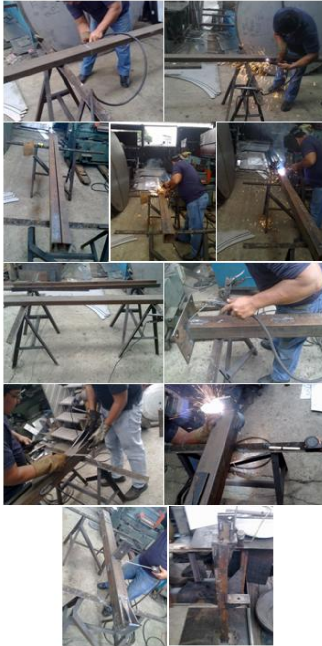
FIGURA 2.20. CONSTRUCCIÓN DE LA COLUMNA PRINCIPAL
