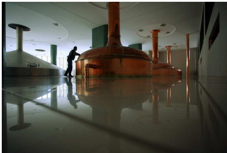
Figura 3-12. Intercambiador de Calor
