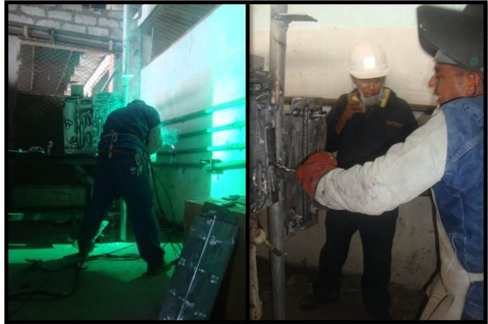
Figura 2. 11.- Área de prueba de soldadura para la calificación
