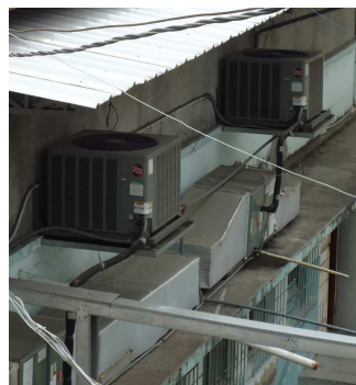
Figura 9. Acondicionadores de aire instalados
