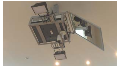
Figura 4. Instalación de los componentes
