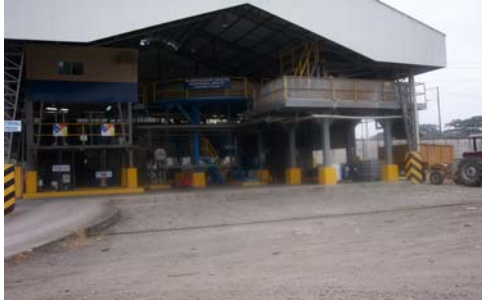
Fig # 12: Vista General de Planta de Clarificación de los Efluentes de PANASA
