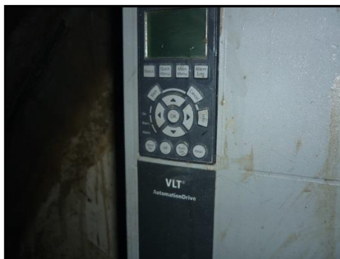
Figura 3.11. Variador de frecuencia.
