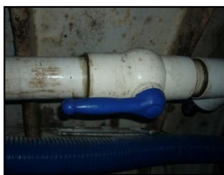
Válvula de evacuación lastre
