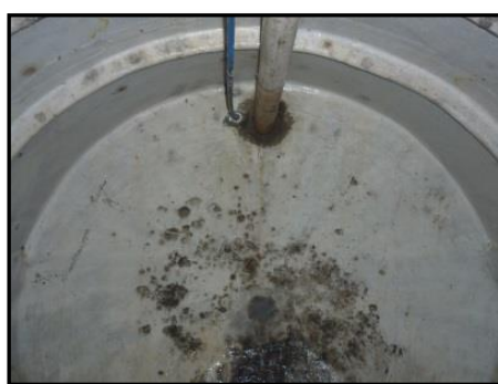
Sistema de soplado lastre.
