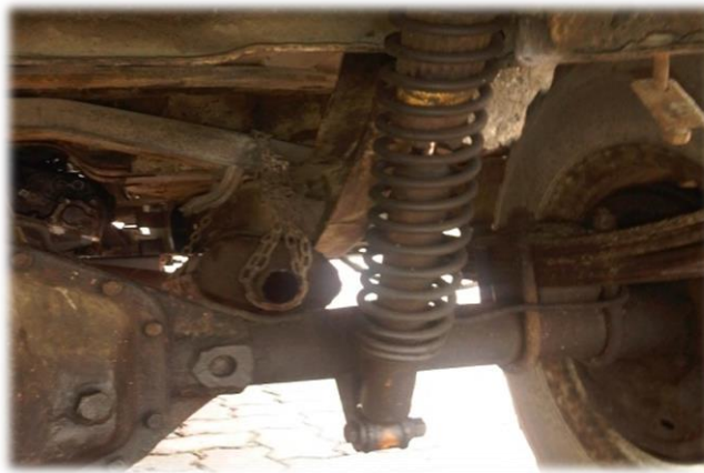
Fotografía 2.1.1 La tubería de escape se encuentra con fugas en la junta del múltiple de escape y una rotura de la tubería a la salida del silenciador
