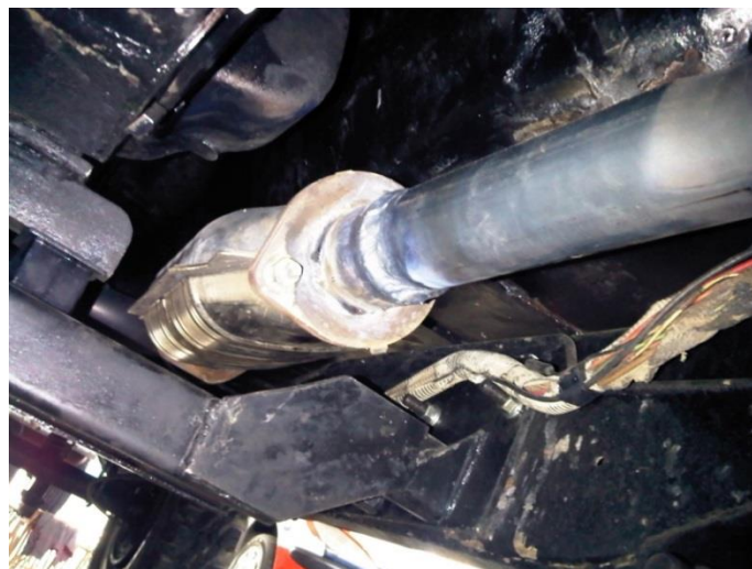
Fotografía 4.1.2 Muestra el catalizador instalado entre el silenciador y el múltiple de escape, después se incorpora el silenciador y de allí la tubería de salida de donde serán tomadas las muestras de una manera más precisa sin tener fugas en el sistema.
