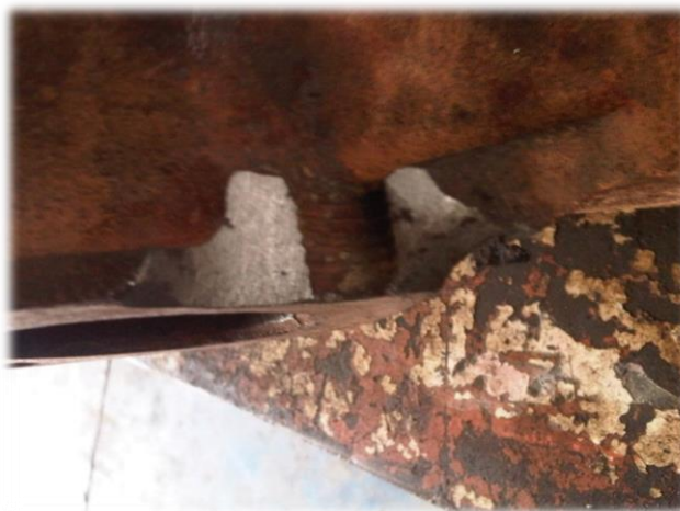
Fotografía 2.1.2 Extraído el múltiple de escape también presenta roturas en la base de unión con la tubería. Se realiza una reparación de la base del múltiple de escape, fabricando la pieza que complementa la misma con acero A36 y realizando un trabajo de soldadura con Níquel 60 para Hierro Fundido Nodular, material del que está hecho el múltiple de escape.
